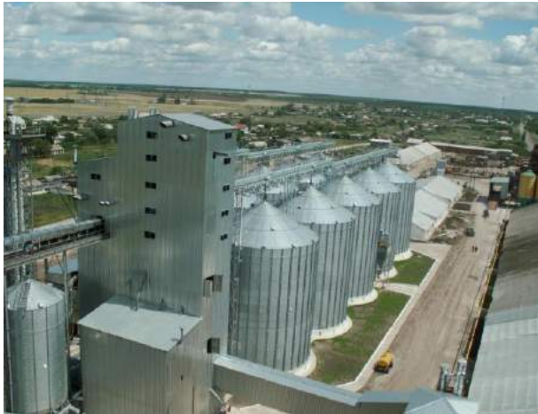
Рисунок 1 - Будівля елеватора та допоміжні споруди
