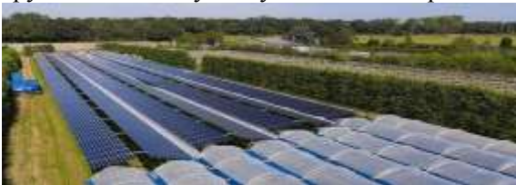
Рис. 1. Напівпрозорі сонячні панелі вкрили плантації малини у Нідерландах [3]
