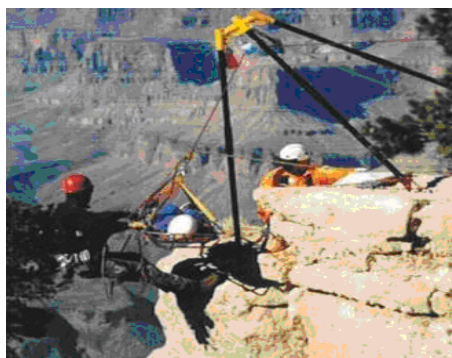
Рисунок 2.14. Спуск потерпілого із супроводом з використанням рятувальної тринози та рятувальних ношей
