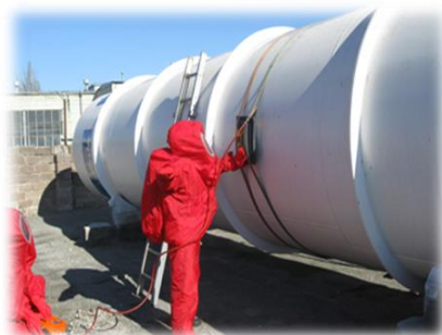
Рисунок 3.3. Закриття отворів на магістралях і резервуарах за допомогою бандажів
