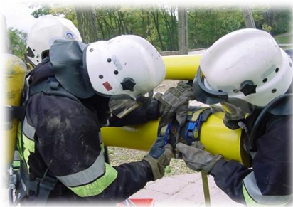
Рисунок 3.4. Ліквідація вилу (викиду) НХР за допомогою хомутів
