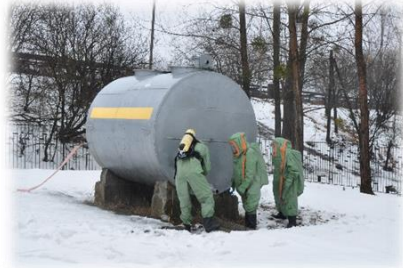
Рисунок 3.2. Перекриття кранів і засувок на магістралях подачі НХР до місця аварії
