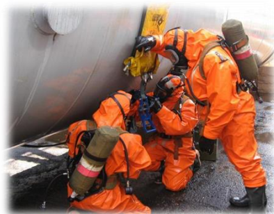
Рисунок 3.3. Закриття отворів на магістралях і резервуарах за допомогою бандажів
