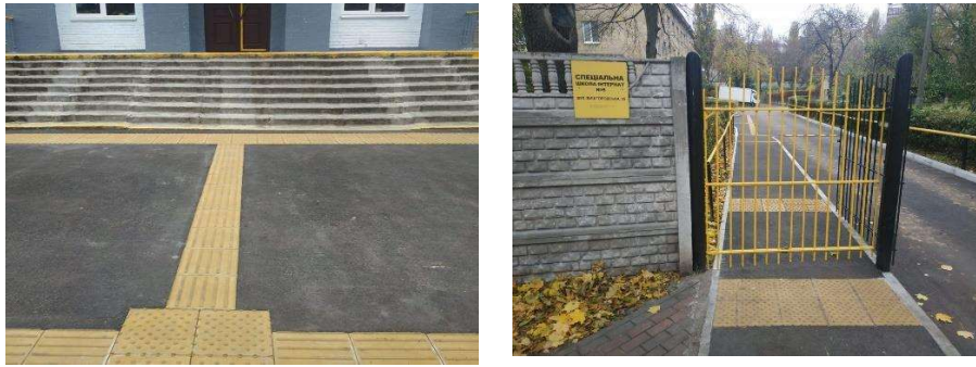
Рисунок 1 – Приклади облаштування тактильної плитки та світловідбиваючого маркування
