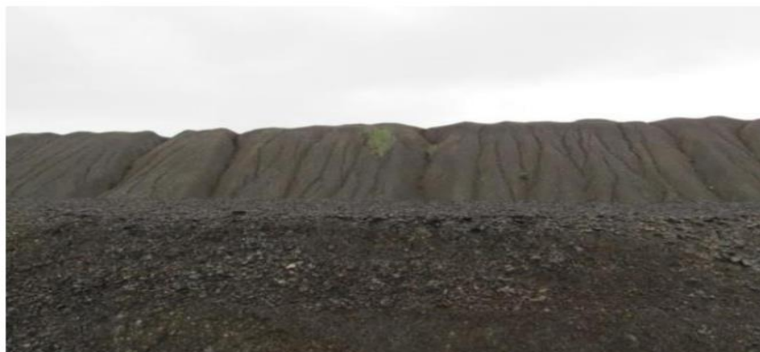
Рисунок 1.1 – Процеси водної ерозії на схилі відвалу на території Нововолинського гірничопромислового регіону (фото В. В. Поповича)
