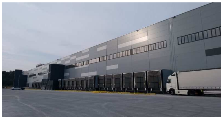
Рисунок – 1.4 Розподільчий центр Protec Zymna Voda (зображення взято з сайту: https://protec-lpk.com.ua/protec-zymna-voda )
