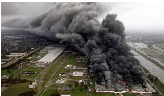
Рисунок – 1.18 Гасіння пожежі в складському приміщенні заводу General Electric (зображення взято з сайту: https://www.courier-journal.com/story/news/local/south/2015/04/03/fire-general-electric-appliance-park-louisville/25231963/ )
