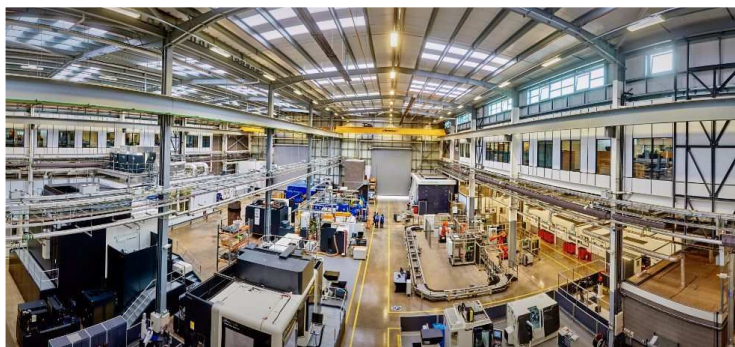
Рисунок – 1.1 Виробничо-складська будівля ТОВ "Спецбудмаш" Київська область, місто Бровари (зображення взято з сайту: http://itbud.com.ua/ )
