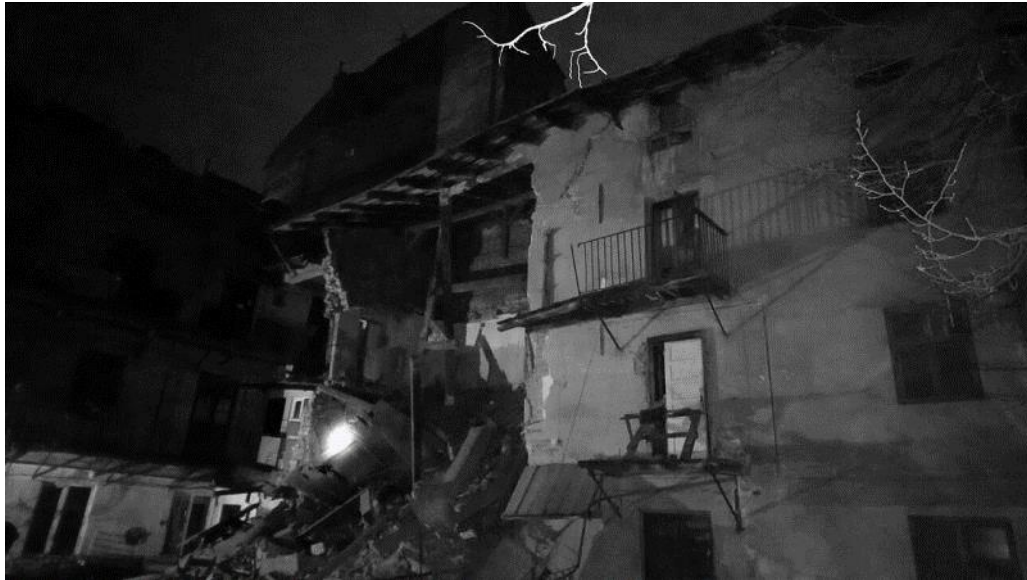
Рисунок 1.6 – Обрушення частини стіни під час пожежі
