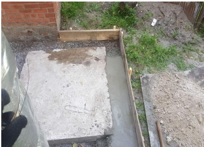
Рисунок 4.7 – Підготовка фундаменту малогабаритної установки для дослідження теплового впливу пожежі на будівельні конструкції
