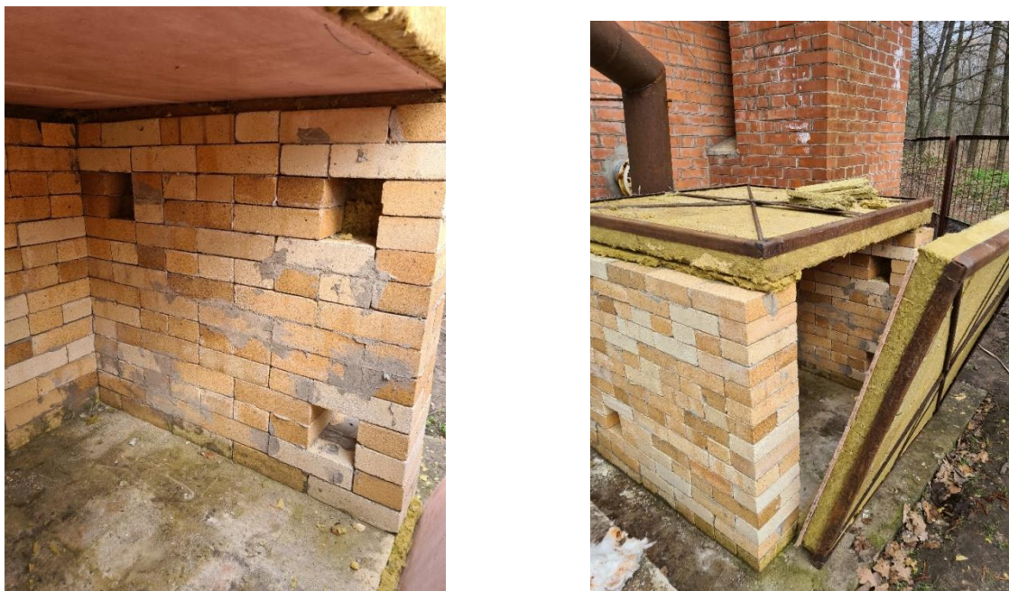
Рисунок 4.10 – Фото камери печі та установки ззовні напередодні проведення тестових запусків
