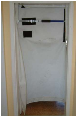
Рисунок 6. Приклад встановлення протидимової завіси
