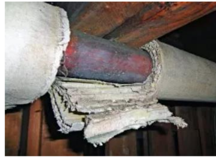
Рис. 1. Ліворуч: компанія Hercules виготовила комерційну азбестову тканину, що містить щонайменше 75% азбесту 2. Праворуч: трубна ізоляція, що містить азбест
