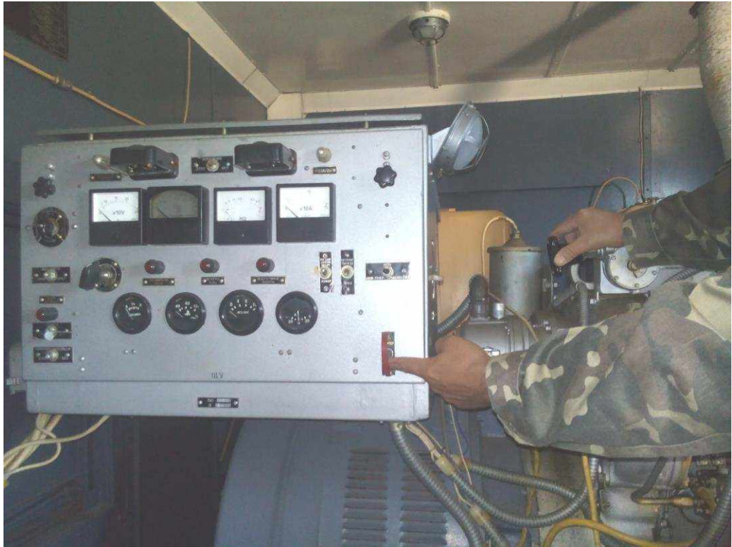
Рис. 3.21 (б). Вмикання агрегату живлення АД-30
