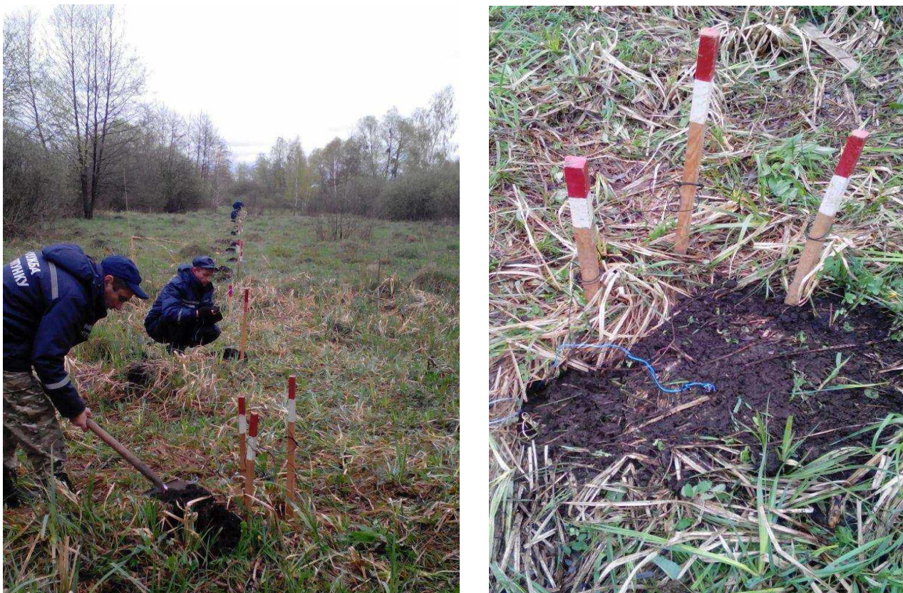
Рис. 4.4.5. Порядок засипки шпурових зарядів
