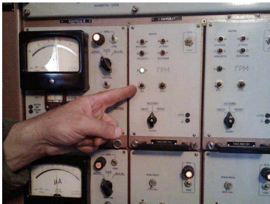
Рис. 3.19 (в). Вмикання апаратури ПРМГ-76У
