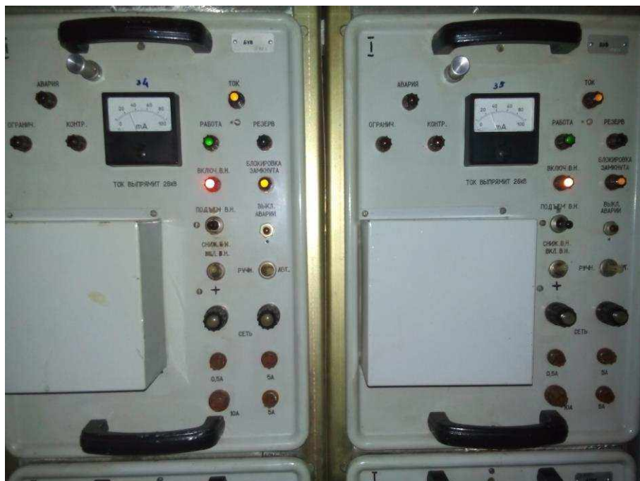
Рис. 3.21 (в). Перевірка вмикання передавачів ДРЛ
