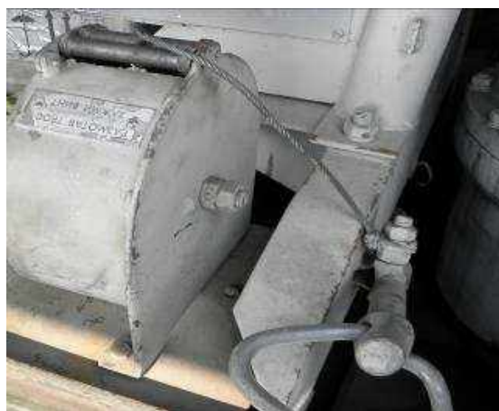
Рис.1.6 (в.) Згорнути силові кабелі
