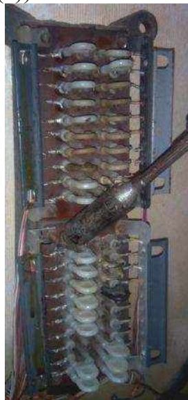
Рис.3.7 (а). Монтаж міжміського боксу
