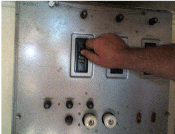
Рис. 3.24 (б). Ввімкнення автомату «СЕТЬ»
