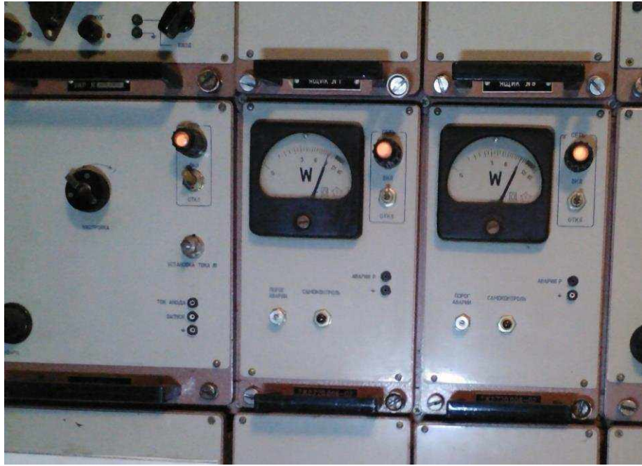
Рис. 3.19 (в). Перевірка потужності РД КРМ (ГРМ)
