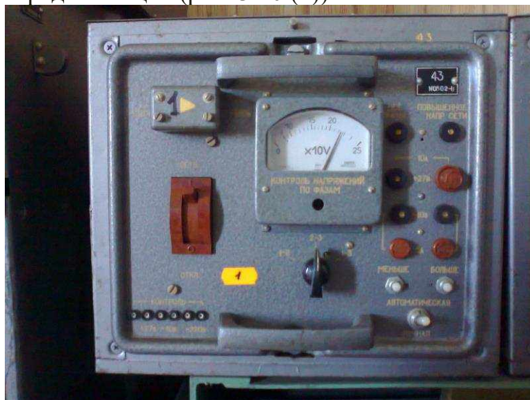
Рис. 3.10 (б). Вмикання радіостанції на блоці 43
