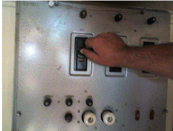
Рис. 3.25 (а). Вимкнення автомату "СЕТЬ"
