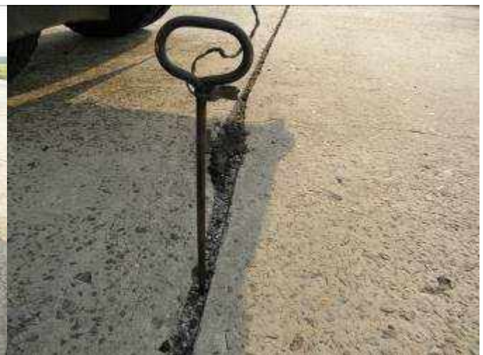
Рис.1.5 (б). Встановлення заземлення
