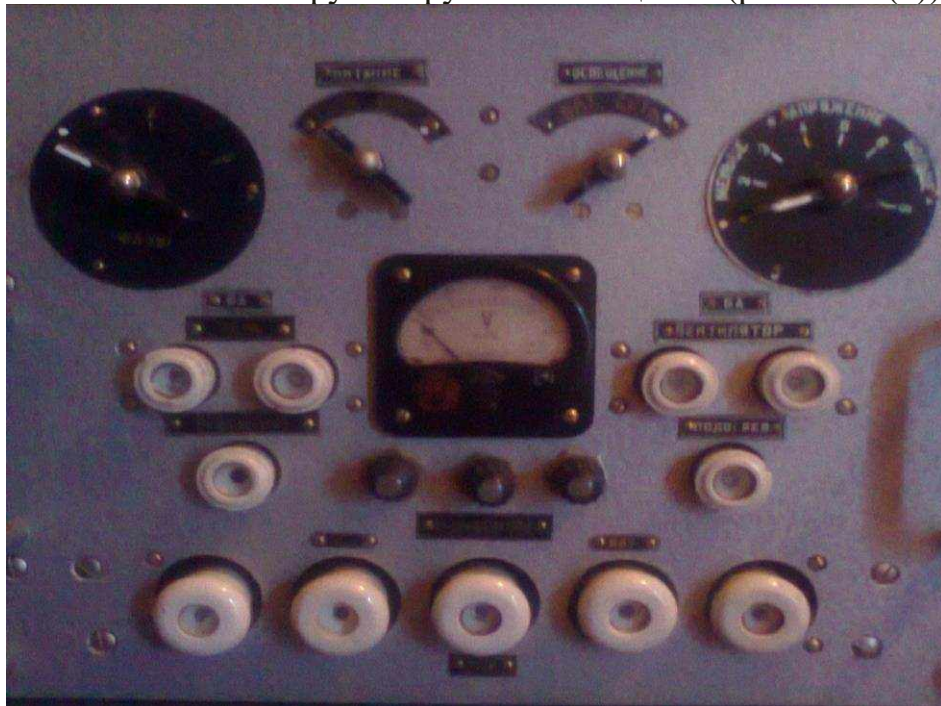
Рис. 3.16 (в). Вмикання радіостанції на блоці автотрансформатора
