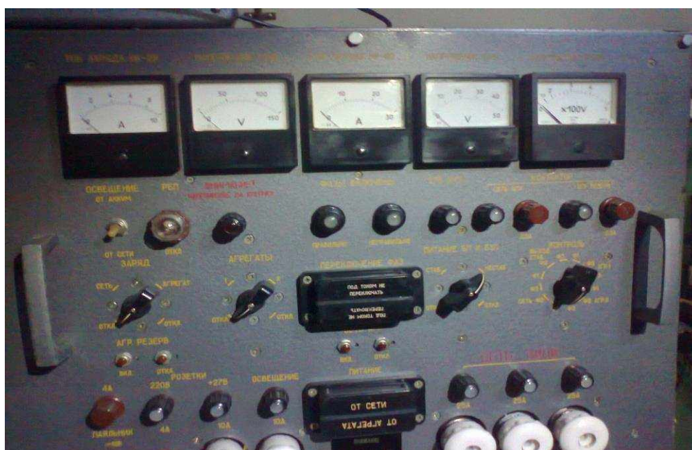
Рис. 3.12 (б). Розподільчий щит
