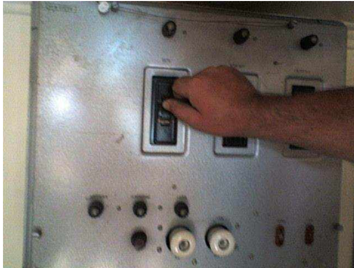
Рис. 3.26 (а). Вимкнення автомату «СЕТЬ»
