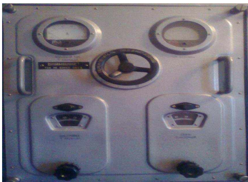
Рис. 3.16 (е). Перевірка струму в антені.
