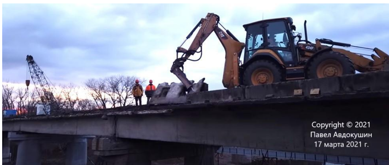
Рис.1 –Робочий момент демонтажу збірного тротуару (автор відео П. Авдокушин)
