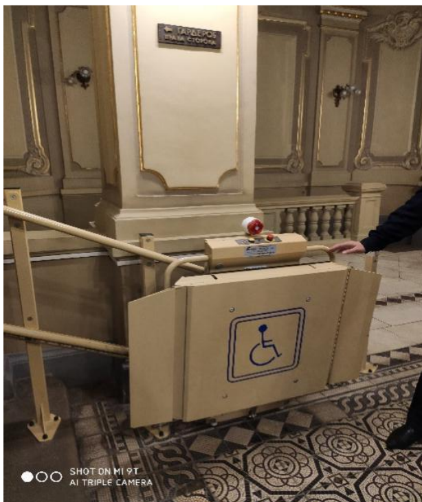
Рисунок 1 – Підйомний пристрій для МГН в будівлі Львівського національного академічного театру опери та балету імені Соломії Крушельницької
