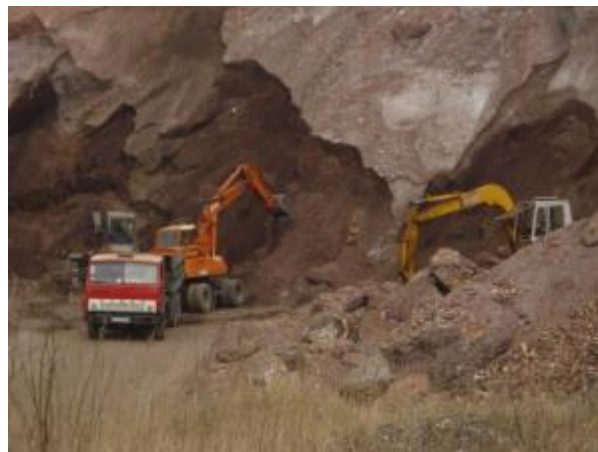
Рисунок 2.2 – Розбирання згаслого терикону для потреб будівництва
