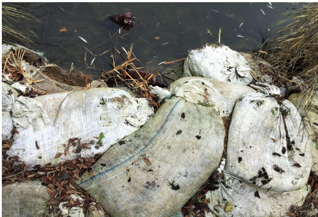
Рисунок 2.6 Закладена мішками пробоїна в дамбі біля с. Верхня Вільхова, листопад (2019 р.) [4]
