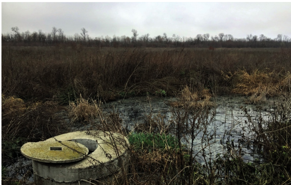
Рисунок 2.5 Витік каналізаційних вод з колектору біля КПВВ «Майорське» (2019 р.) [16]
