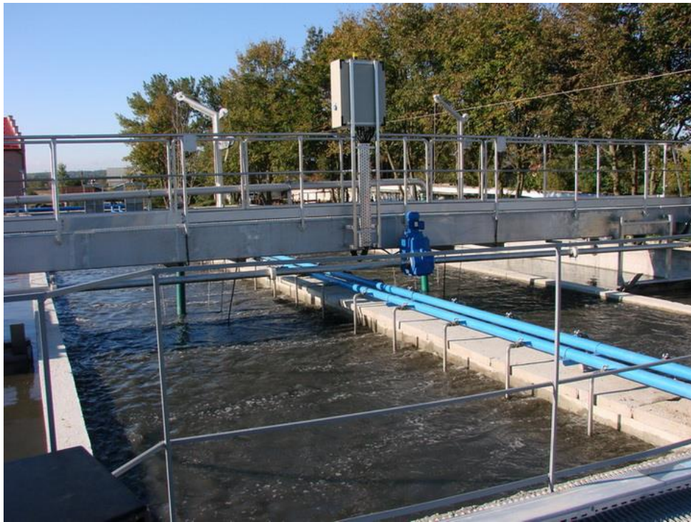
Рис. 2.3. Аеробне очищення стічних вод [42]
