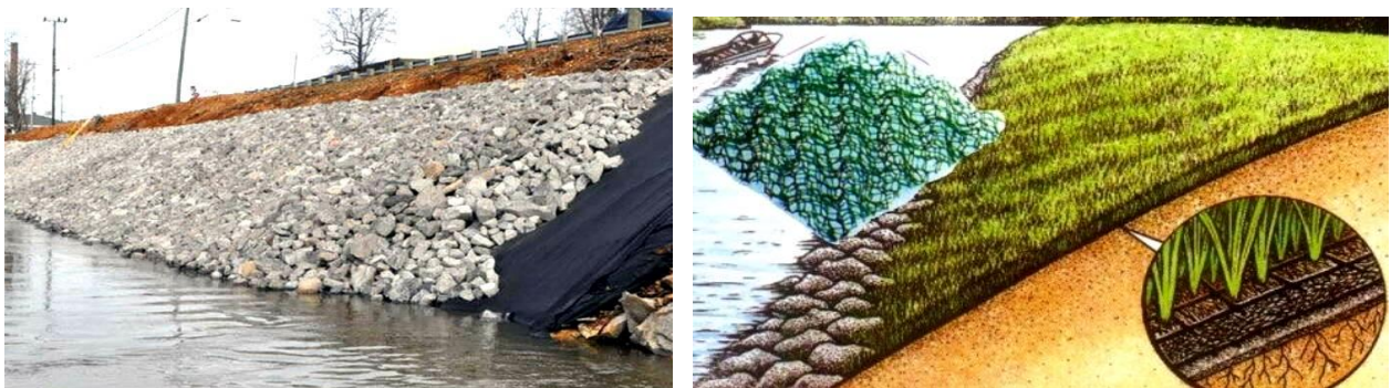
Рис. 4.3. Пропоноване укріплення берегової зони в місці витоку вод Добротвірської ТЕС (с. Старий Добротвір)
