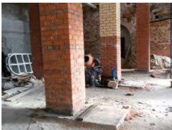
Рисунок 1.4 – Сталеві будівельні конструкції, захищені цегляною кладкою
