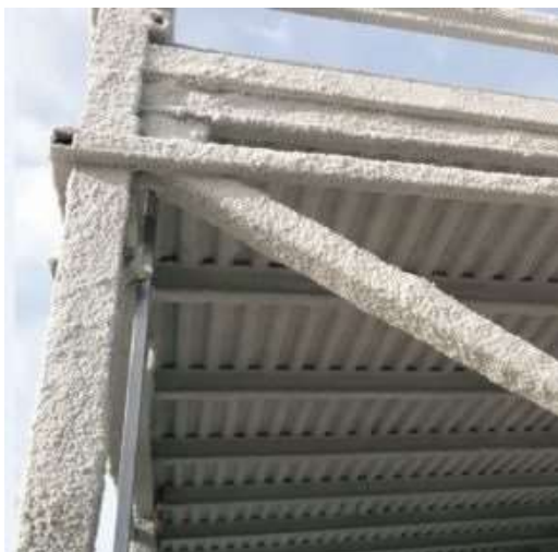
Рисунок 1.3 – Сталеві будівельні конструкції оброблені штукатурним вогнезахисним покриттям
