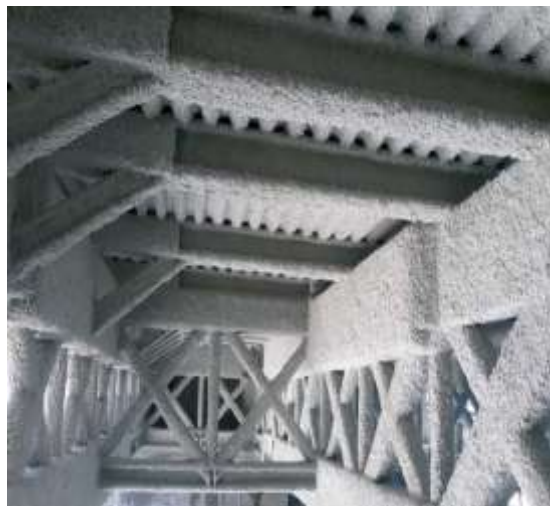
Рисунок 1.3 – Сталеві будівельні конструкції оброблені штукатурним вогнезахисним покриттям
