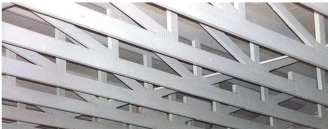
Рисунок 1.11 – Дерев'яна конструкція, захищена латексним покриттям.
