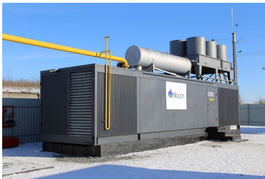
Рисунок 2.13 – Установка з дегазації Хмельницького полігону твердих побутових відходів [172]
