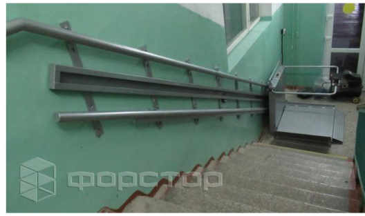
Рис. 4. Встановлення похилих підйомників на двох рівнях у загальноосвітній школі
