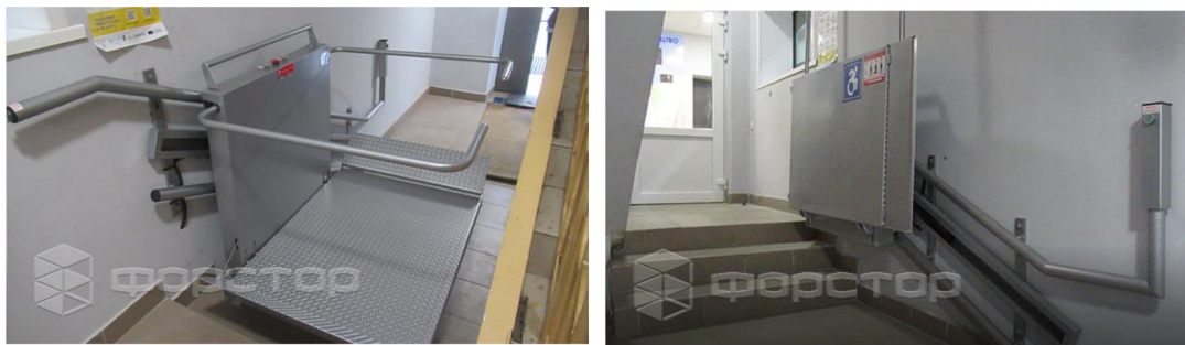
Рис. 2. Встановлення похилого підйомника на шляху евакуації на об'єкті муніципальної інфраструктури
