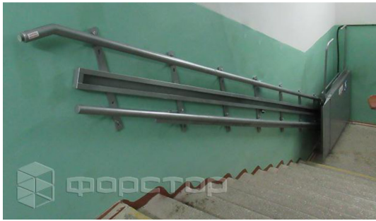
Рис. 4. Встановлення похилих підйомників на двох рівнях у загальноосвітній школі
