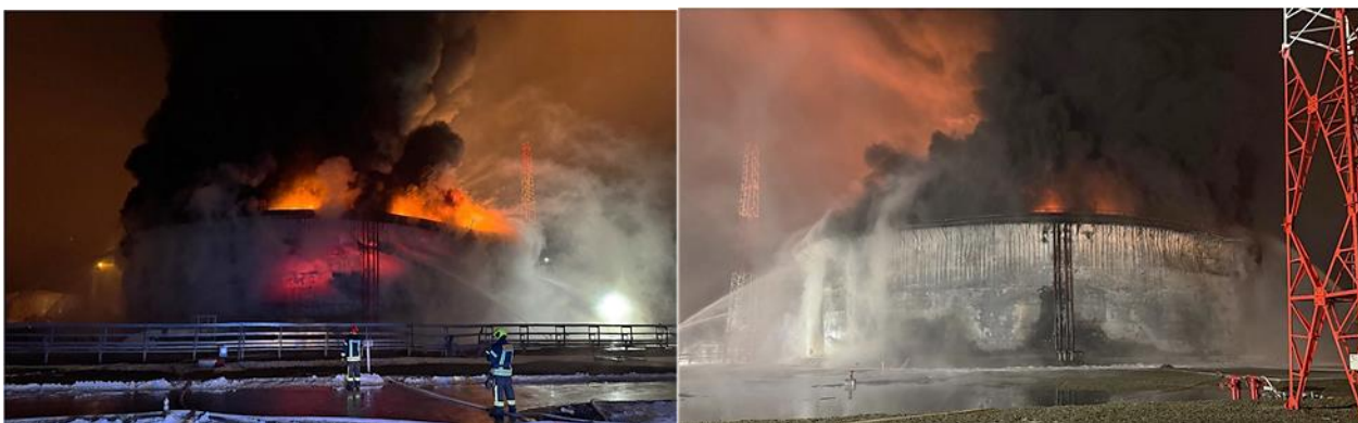
Рисунок 1 – а) вигляд резервуару до пінних атак; б) вигляд резервуару після пінних атак
