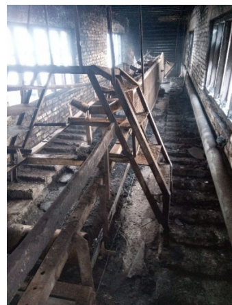
Рисунок 1 – Наслідки пожежі в галереї подачі первинної сировини на підприємстві з виробництва брикетів торфу
