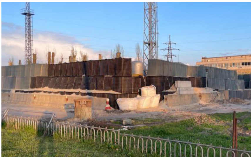
Рисунок 1 – Збірні перешкоди (конструкція із габіонів) [2]
