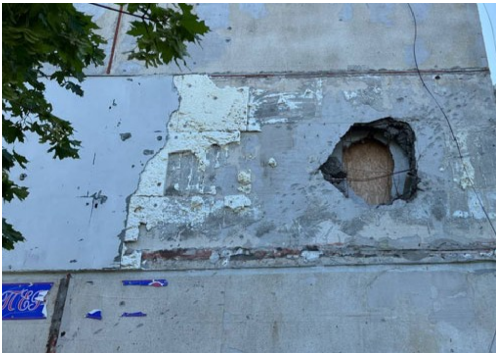
Рисунок 1– Приклад руйнування зовнішньої стіни (Харків, Північна Салтівка, серпень 2025)
