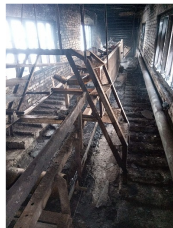
Рисунок 1 – Наслідки пожежі в галереї подачі первинної сировини на підприємстві з виробництва брикетів торфу
