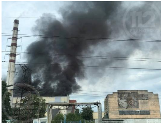
Пожежа на покрівлі машинного залу внаслідок загоряння турбінного масла у турбогенераторі Бурштинської ТЕС
