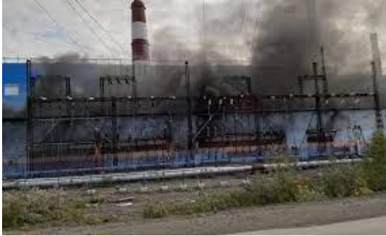
Наслідки загоряння турбінного масла турбогенератора з наступним вибухом водню
