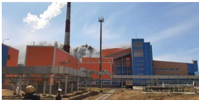
Рисунок 4 – Пожежа на покрівлі машинного залу внаслідок вибуху водню у корпусі турбогенератора енергоблоку
