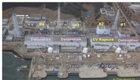
Рисунок 2 – Вибух (детонація) водню на першому, третьому та четвертому енергоблоках після вентиляційних операцій на АЕС “Фукусіма-1”
