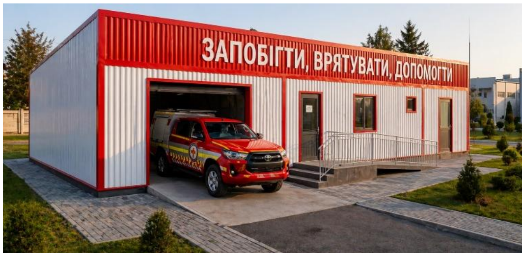
Рис. 1 – Вид модульного пожежного депо
