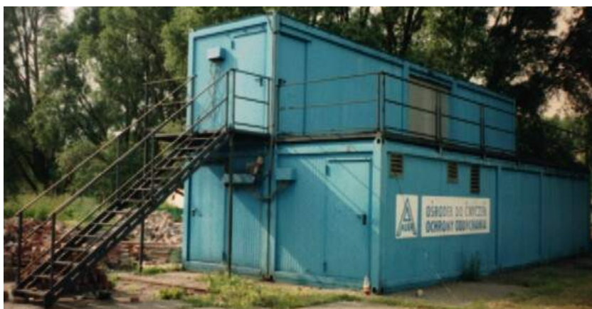
Рисунок 5 – Загальний вигляд ТДК контейнерного типу
