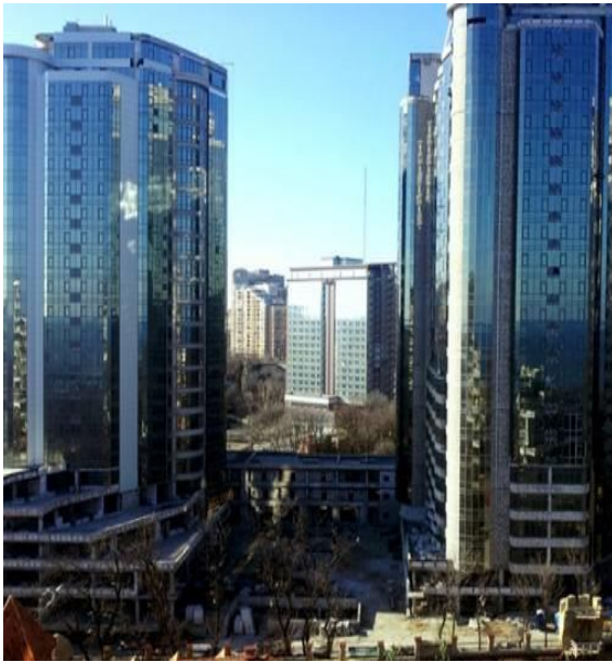
Рис. 1. Вигляд житлового комплексу до пожежі
