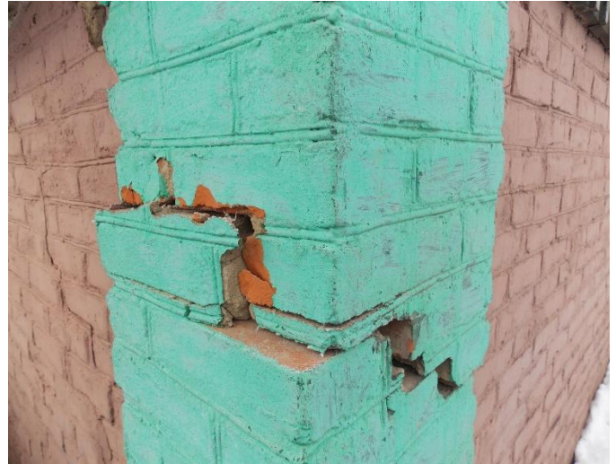
Рис. 5. Фотографія стін будівель які зазнали руйнувань в селах Бакути та Тимофіївка з 6-ти бальними значеннями інтенсивності землетрусу 03.02.2015
