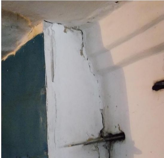
Рис. 5. Фотографія стін будівель які зазнали руйнувань в селах Бакути та Тимофіївка з 6-ти бальними значеннями інтенсивності землетрусу 03.02.2015
