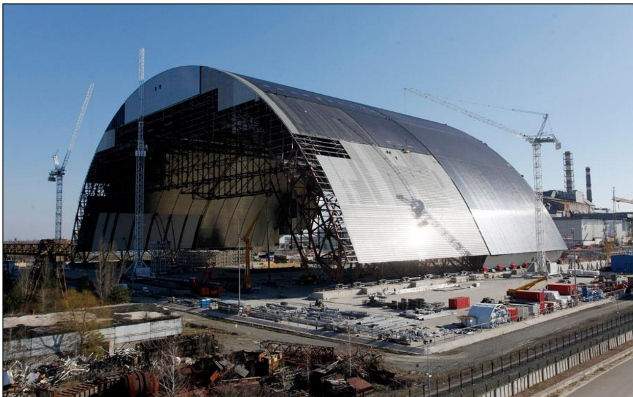
Рис.4. Будівництво конфайнмента наближається до завершення (Фото УНІАН)
