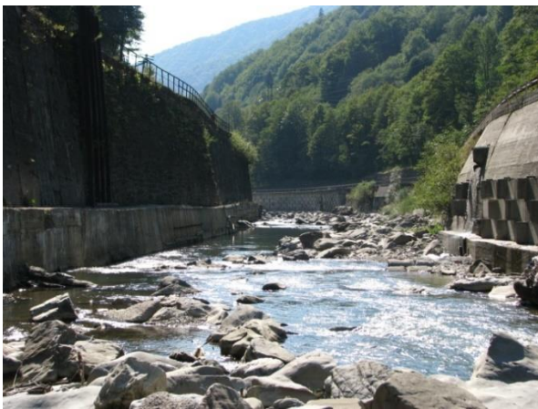
Рис.1. Фото небезпечної ділянки залізниці .
