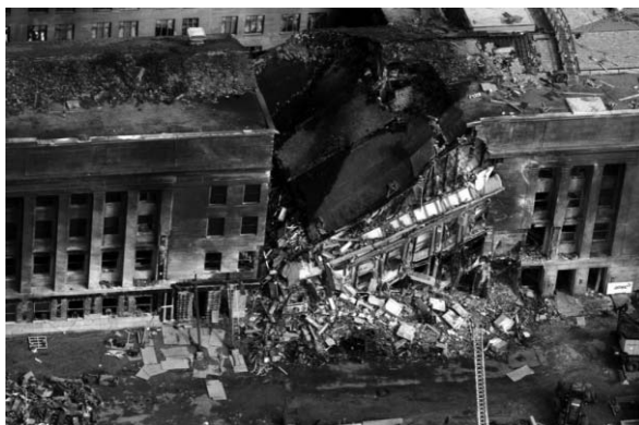
Рисунок 2 - Прогрессирующее обрушение наружного кольца здания Пентагона во время террористической атаки 11 сентября 2001 года
