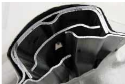
Рисунок 3.3 – Поперечний переріз середньої стійки, мод. 2002
