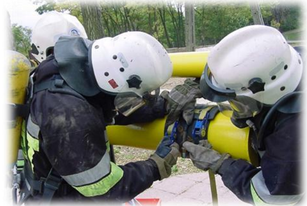
Рис. 1.4. Ліквідація вилу (внкнду) НХР за допомоогою хомутів
