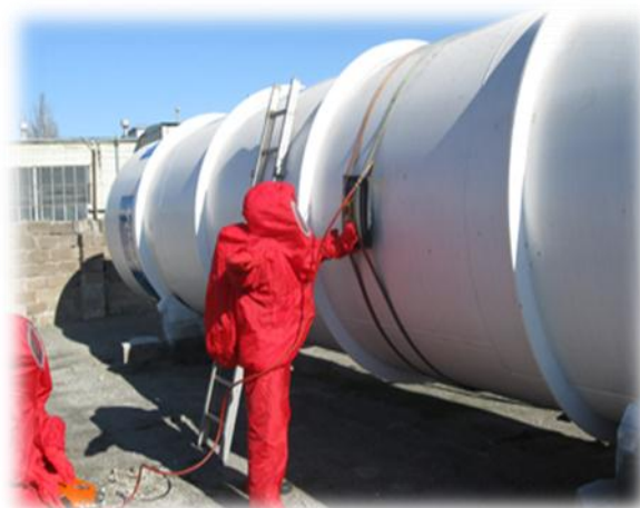
Рис. 1.3. Ліквідація виліву (викиду) НХР за допомогою бандажів
