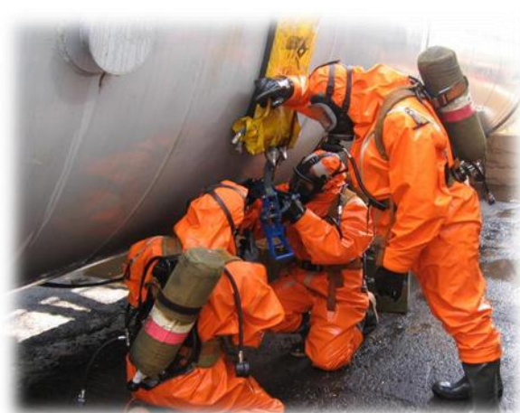
Рис. 1.3. Ліквідація виліву (викиду) НХР за допомогою бандажів
