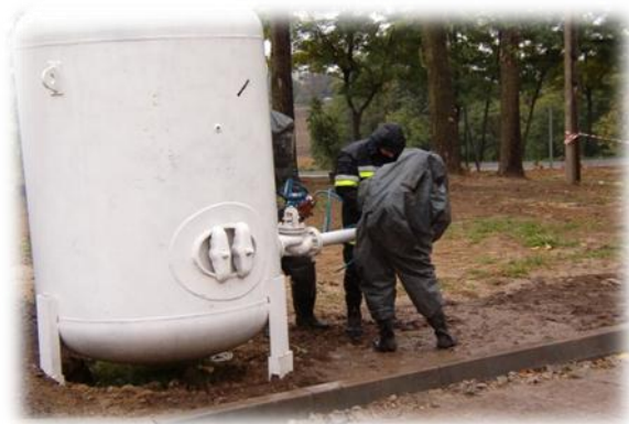
Рис. 1.2. Перекриття кранів і засувок з НХР
