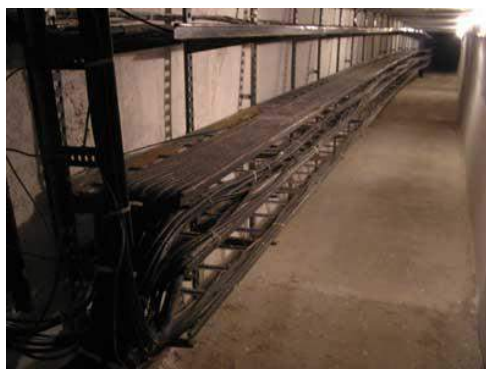
Рис. 1. Приклад кабельного тунелю прямокутного перерізу
