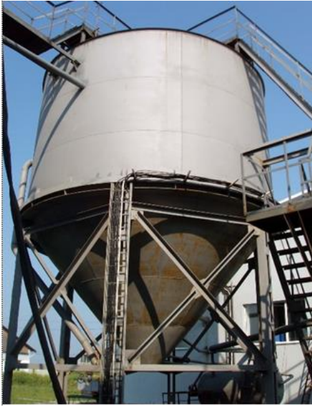
Відстійник-флотатор діаметром 7,2 м
