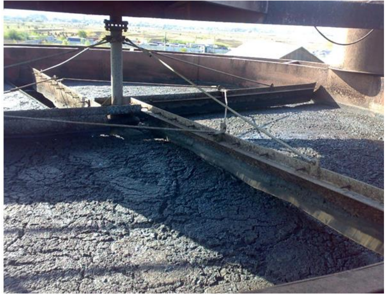
Видалення флотошламу з поверхні відстійника-флотатора
