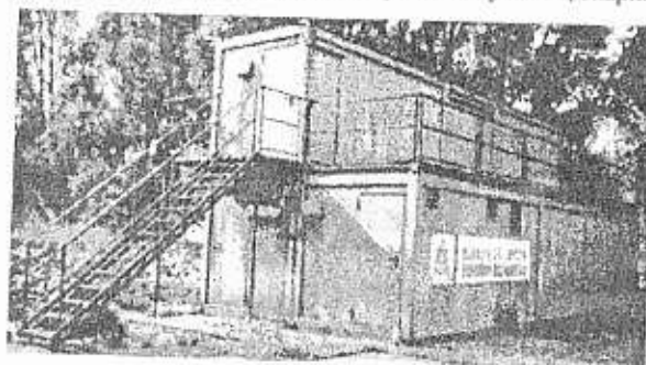
Рис. 2. Загальний вигляд ТДК контейнерного типу
