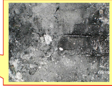
Обвуглювання деревини під покриттям
