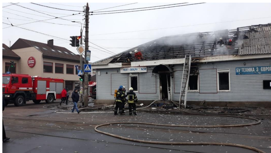
Рисунок 1.3 – Пожежа в магазині з подальшим поширюванням на суміжні будівлі
