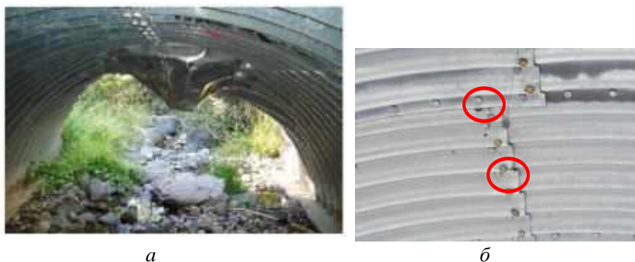
Рис. 1. Пошкодження металевих гофрованих конструкцій у процесі експлуатації: a – провисання склепіння труби із МГК та розвиток пластичного шарніру; б – викрившування металу в зоні болтових з'єднань.
