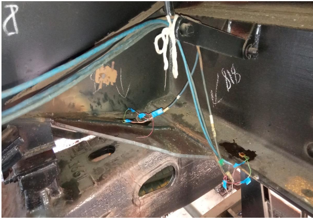
Рис. 6. Місце встановлення накладок
