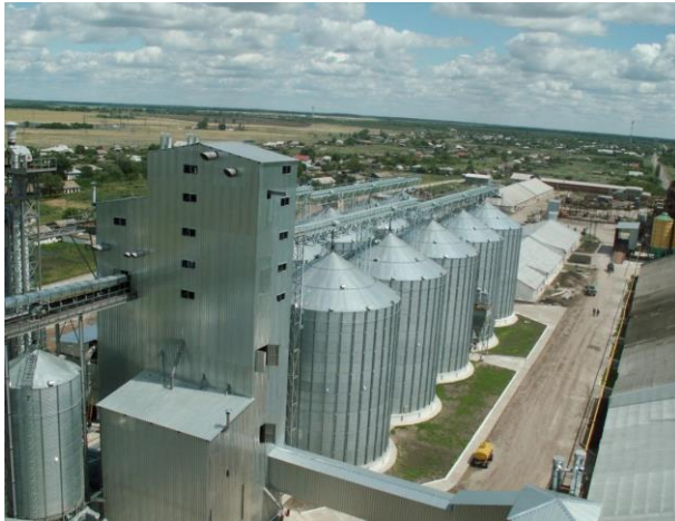
Рисунок 1 - Будівля елеватора та допоміжні споруди
