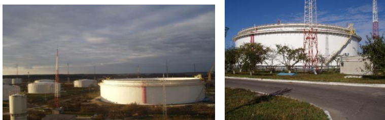
Рисунок 1 - Резервуар 75 000 м 3 на НПС “Броди”
