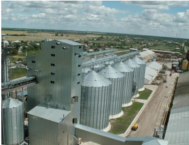
Рисунок 1 - Будівля елеватора та допоміжні споруди
