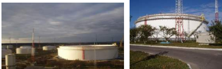
Рисунок 1 - Резервуар 75 000 м 3 на НПС “Броди”
