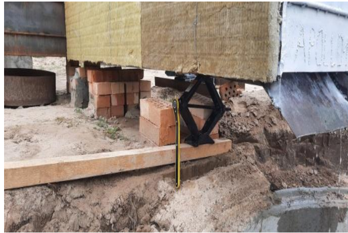
Рисунок 3.9 – Регулювання ухилу маслоприймача автомобільним домкратом
