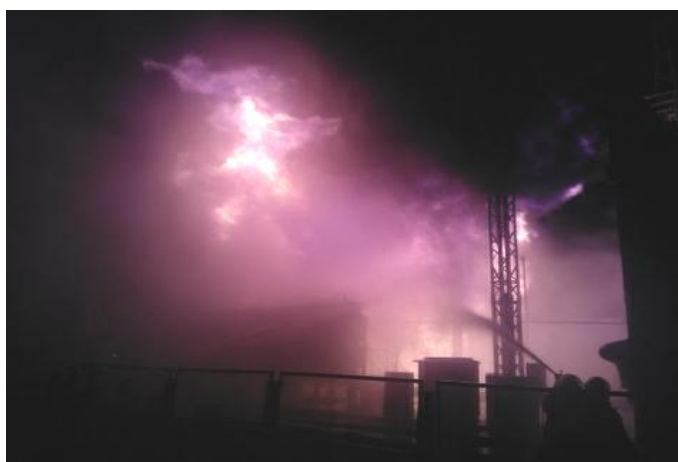
Рисунок 1.1 – Приклад пожежі на перепускнуому трансформаторі ВП «Южно-Українська АЕС»
