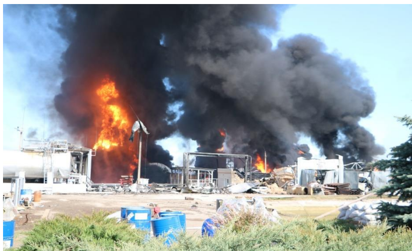
Рис. 1.13. Руйнування та пошкодження значної кількості резервуарів, споруд і технологічних комунікацій на нафтобазах
