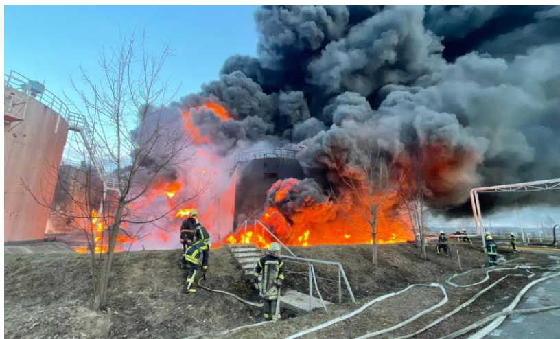
Рис. 1.14. Горіння одночасно групи резервуарів в межах обвалування
