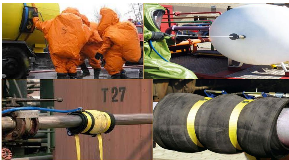
Рис. 3.12. Установки аварійних накладок
