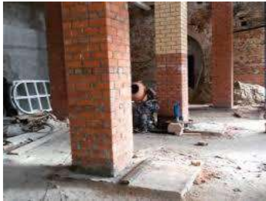
Рис. 1. Металеві будівельні конструкції, захищені цегляною кладкою.
