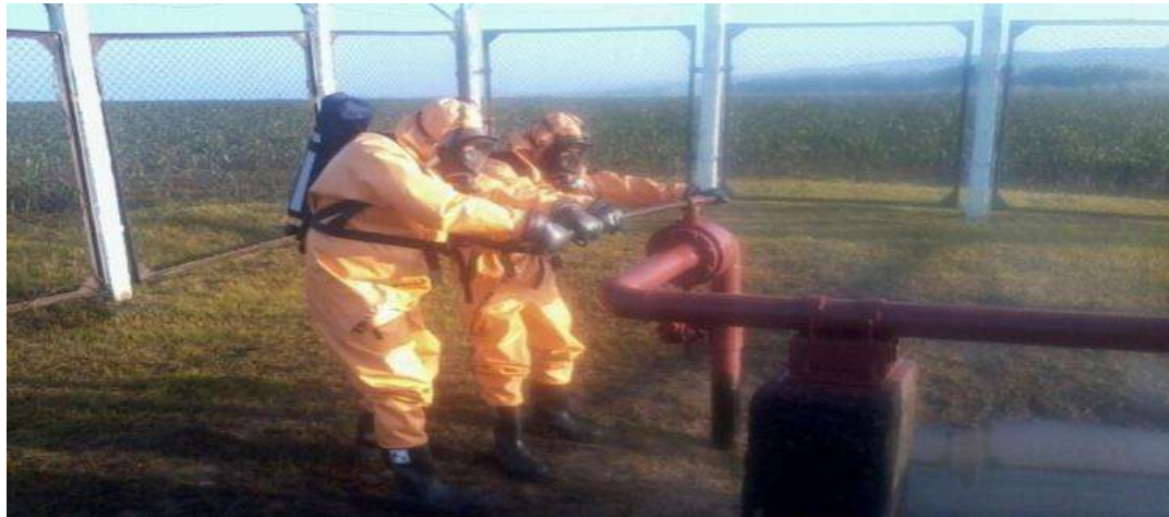
Рис. 3.11. Перекриття кранів і засувок на трубопроводах
