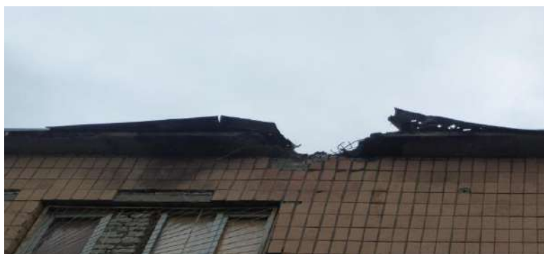
Рис. 8.9. Пошкодження крівлі навчально-спортивного комплексу
