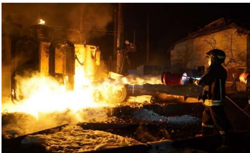
Рис. 1.28. Руйнування та пошкодження технологічного обладнання, споруд і технологічних комунікацій об'єктів енергетики
