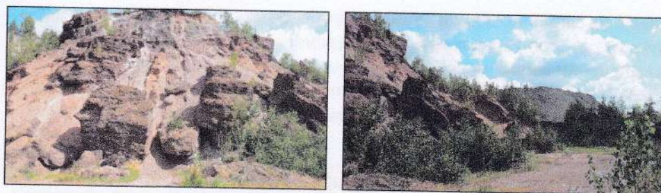
Рис.к 2 – Загальний вигляд породних відвалів териконів шахти № 9 Нововолинського гірничопромислового району (фото автора Босак П.В.)
