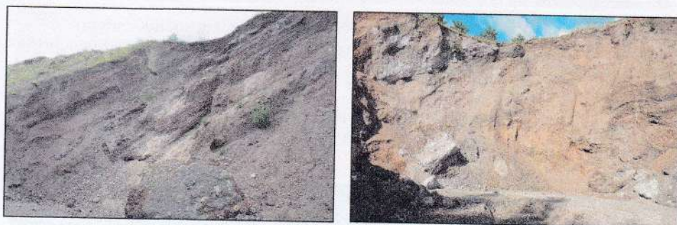
Рис. 3 – Загальний вигляд породних відвалів териконів шахти № 2 Нововолинського гірничопромислового району (фото автора Босак П.В.)
