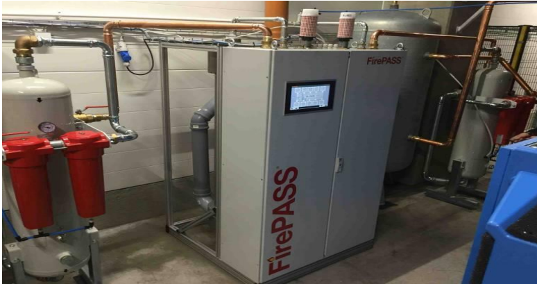
Рисунок 1 – Система зменшення кількості кисню для захисту великих робототехнічних складів High Bay
