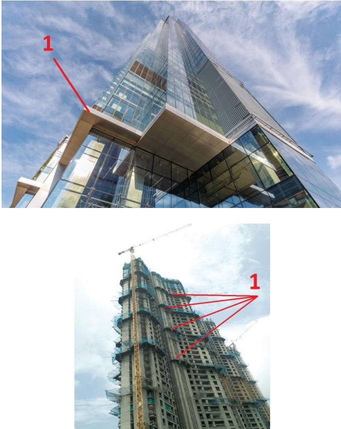
Рисунок 1 – приклад висотних будівель обладнаних протипожежним карнизом (позн. 1)
