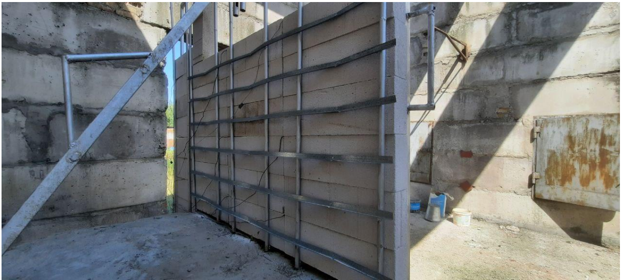
Рисунок 4.17 – тилова сторона установки зі сталевими направляючими для фіксації конструкції фасаду
