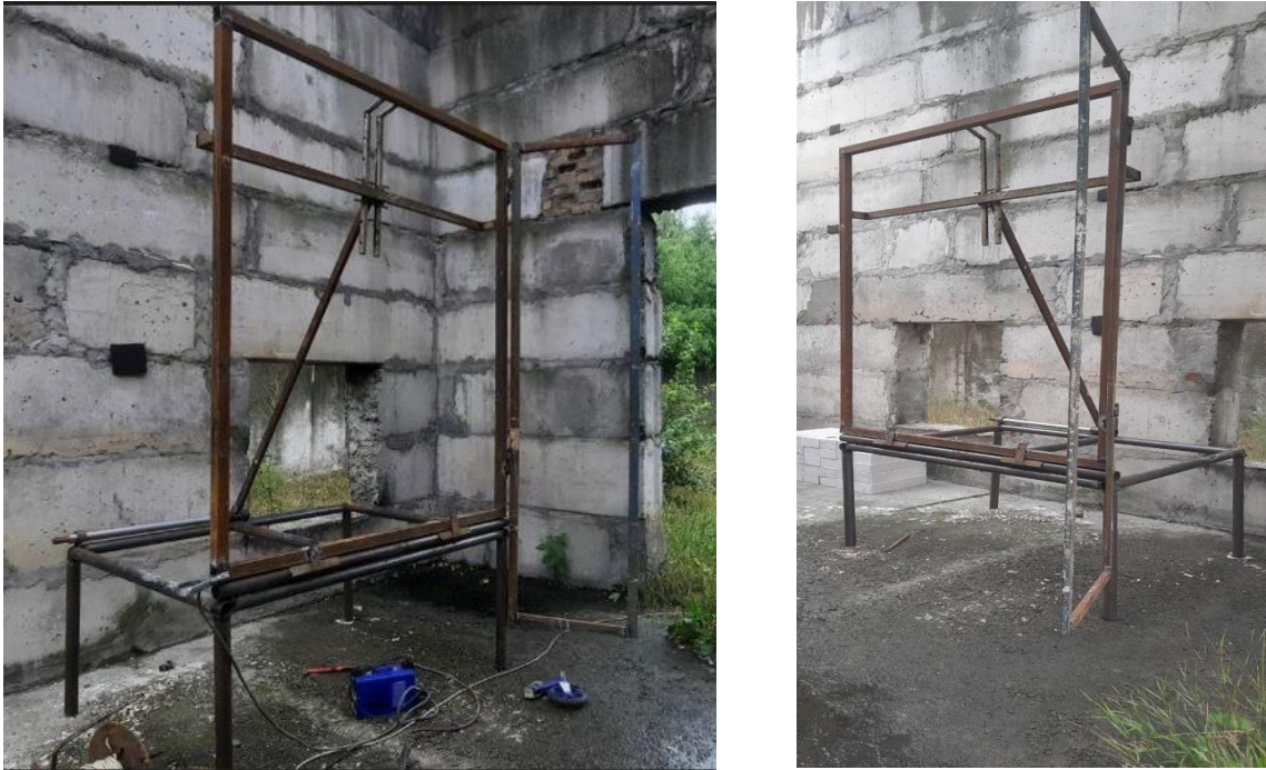
Рисунок 4.13 – Загальний вигляд конструкції рами Випробувальної установки
