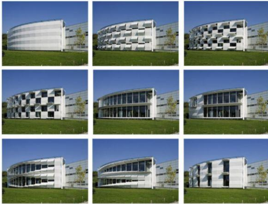
Рисунок 1.19 – фрагменти фото під час функціонування кінетичного фасаду
