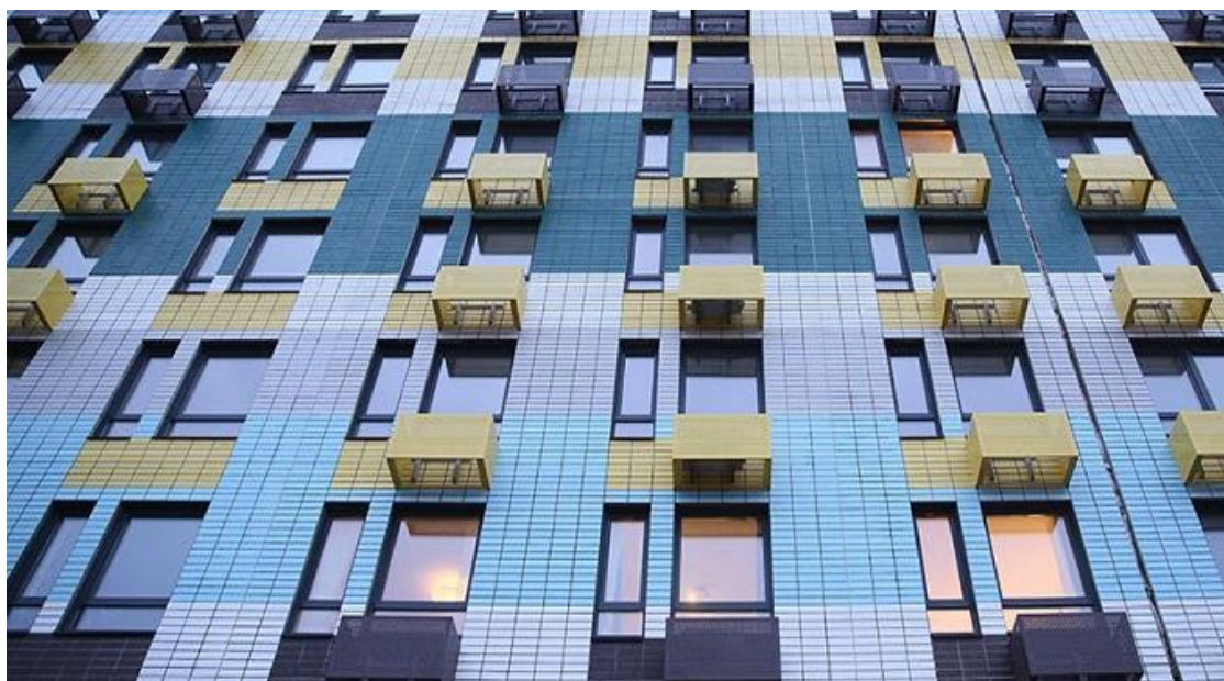
Рисунок 3.2 - Приклад фасадної системи обладнаної корзинами для зовнішніх блоків кондиціонерів з декоративною алюмінієвою композитною панеллю
