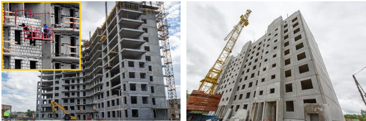
Рисунок 1.10 – Приклад типового моноліт-бетонного фасаду та збірного залізобетонного фасаду з наявністю зовнішніх міжповерхових віконних перешкод: а – монолітно-каркасна будівля; б – будівля із збірних залізобетонних конструкцій
