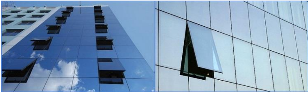
Рисунок 1.13 – Зовнішній вигляд світло-прозорого фасаду із структурним кріпленням скляних модулів до будівельних конструкцій
