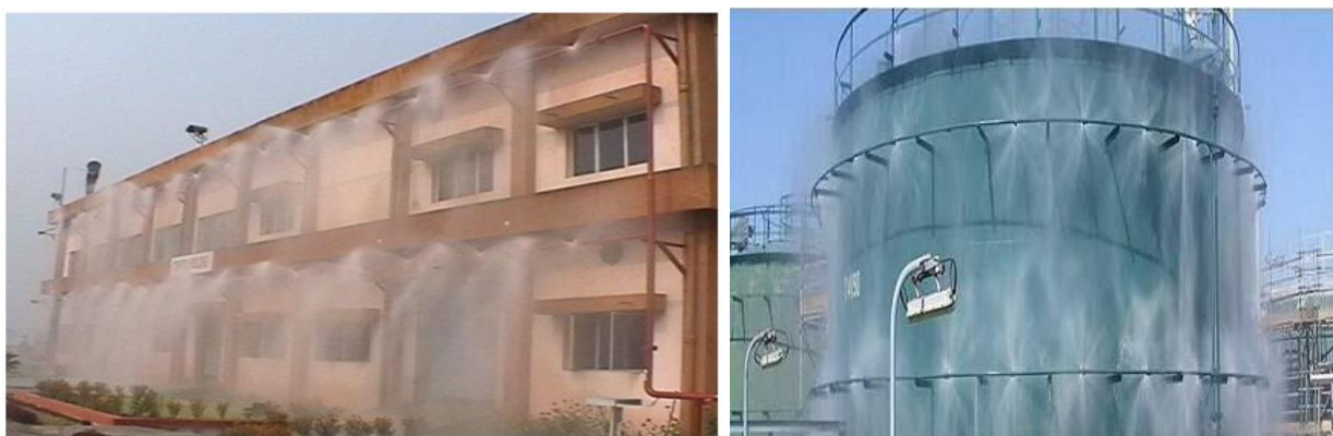
Рисунок 3.24 – Фото систем водяного екранування від пожежі зовнішніх огорожувальних конструкцій
