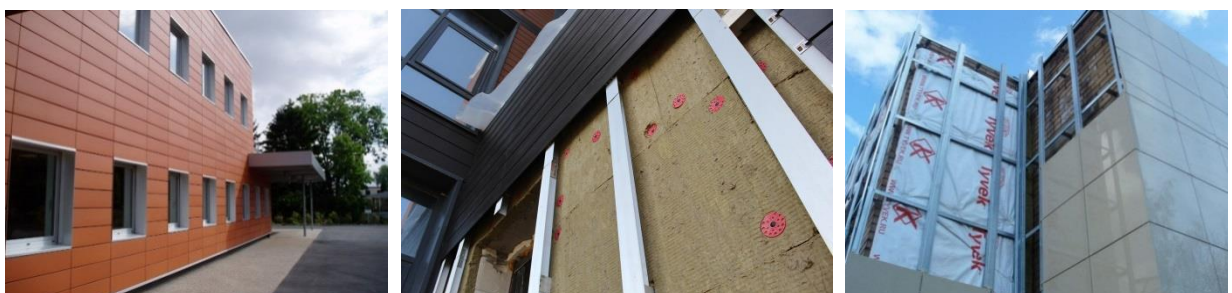
Рисунок 1.7 – Приклад «сухого фасаду» із навісними елементами
