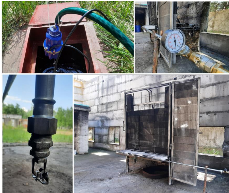
Рисунок 5.8 – Зовнішній вигляд Установки та обладнання для дослідження процесів обмеження поширення пожежі по зовнішнім огорожувальним конструкціям фасадною протипожежною перешкодою активного типу
