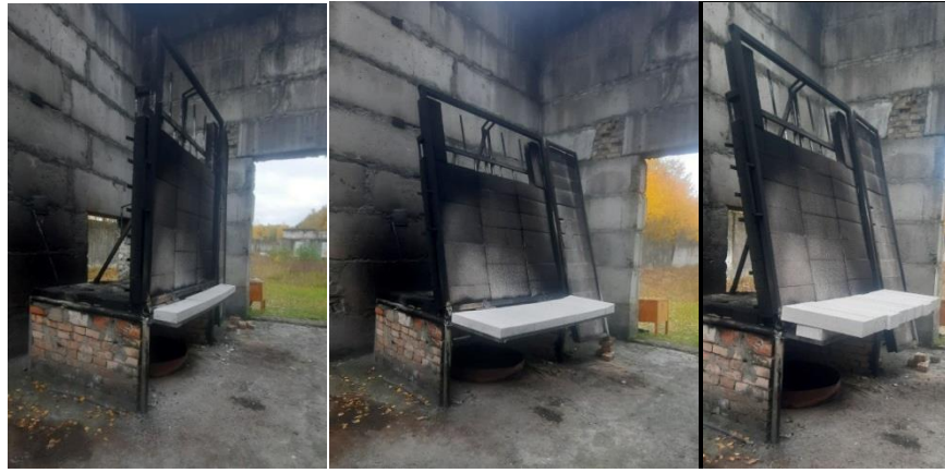
Рисунок 4.18 - Зовнішній вигляд влаштованого протипожежного карнизу
